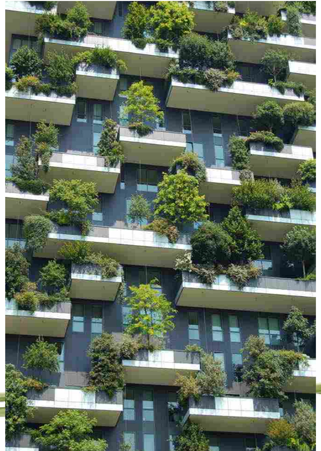
Plus de 2 hectares de forêt garnissent les tours du Bosco Verticale à Milan - architecte Stefano Boeri © Chris Barbalis.
